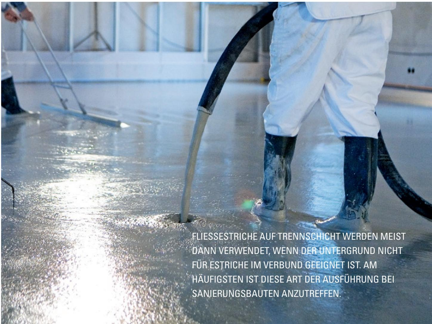
FLIESSESTRICHE AUF TRENNSCHICHT WERDEN MEIST DANN VERWENDET, WENN DER UNTERGRUND NICHT FÜR ESTRICHE IM VERBUND GEEIGNET IST. AM HÄUFIGSTEN IST DIESE ART DER AUSFÜHRUNG BEI SANIERUNGSBAUTEN ANZUTREFFEN.
